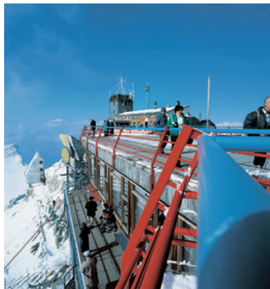
西门子能源变压器使用在阿尔卑斯山上 Siemens Energy transformer on top of the Alps Mountain.
